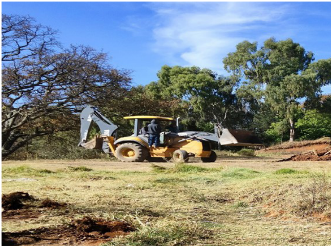
Figura 9. Maquinaria pesada usada para el desmonte y aplanado de un terreno.
