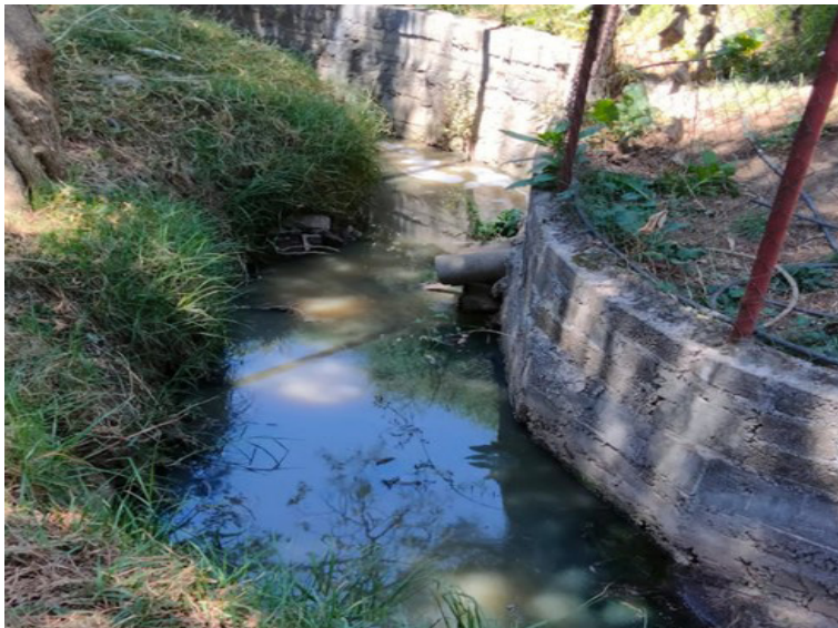
Figura 11. Arroyo utilizado para verter desechos de drenaje.
